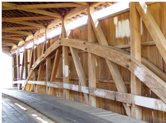
26. ábra. – A Sim Smith híd az eredeti Burr szabadalom alapján kialakított tartóval, ép. 1883
