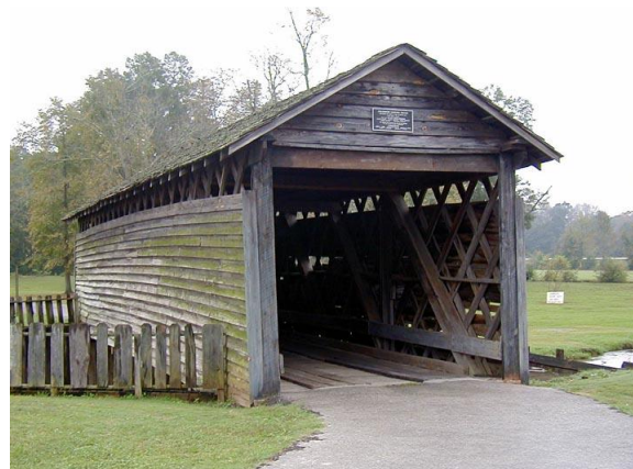
17. ábra. – A Coldwater híd. A tartókra szerelt rácszat a vízszintes palánkozást hivatott megtartani
