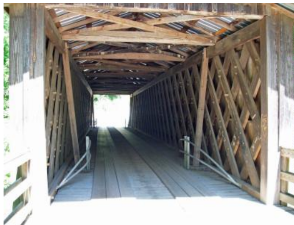
21. ábra. – Elders Mill híd Georgiában, Town-féle rácsos tartóval
