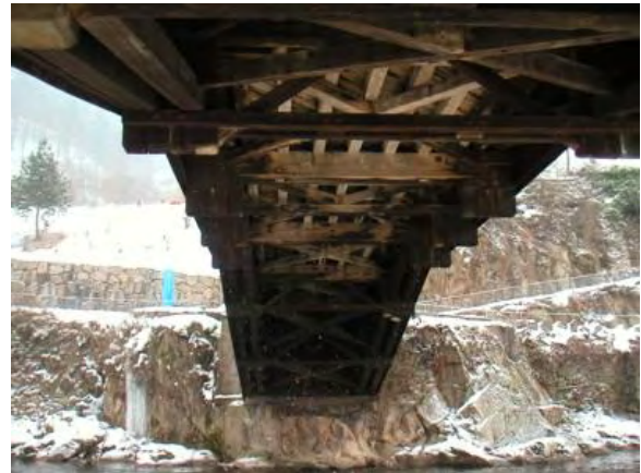
18. ábra. – A Murg hídjának háromszegmensű tartószerkezete
